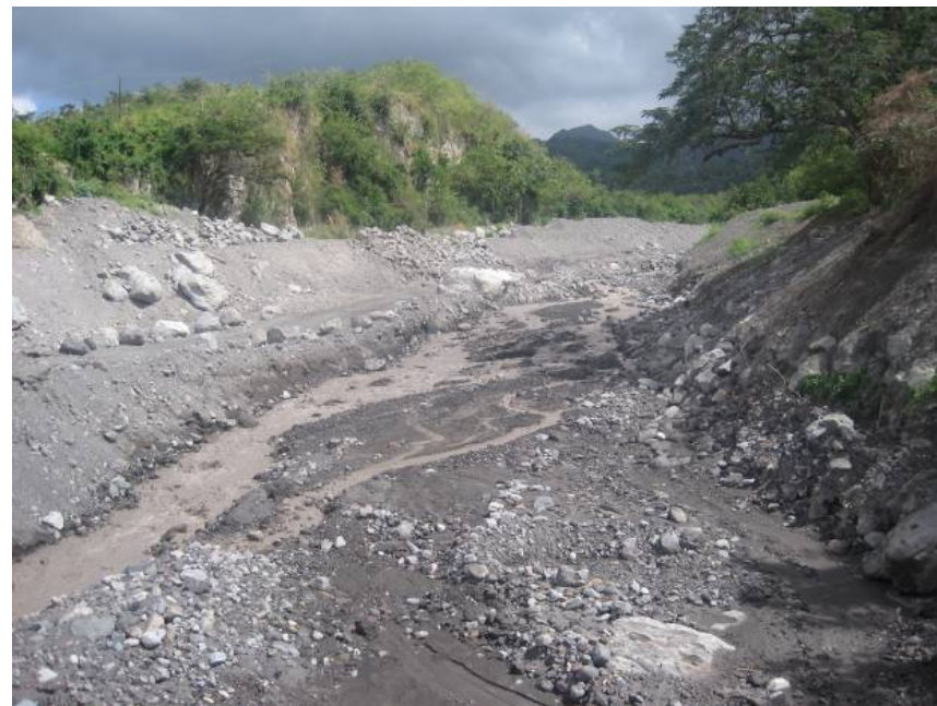
Le lit de la Rivière du Prêcheur très élargie après la crue torrentielle de juin 2010...un lit majeur surdimensionné par rapport à l'écoulement actuel du cours d'eau !
