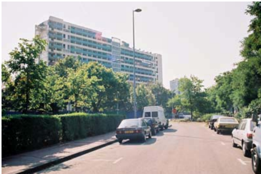
Immeuble Gérard Philipe (le Luth) (en cours de démolition)
