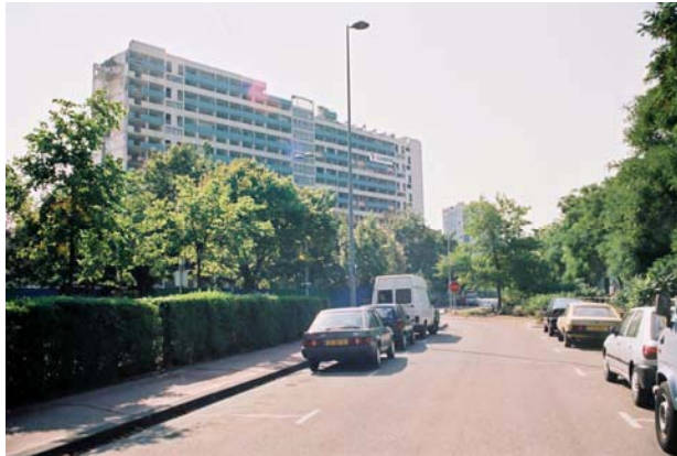
Immeuble du Luth en cours de démolition
