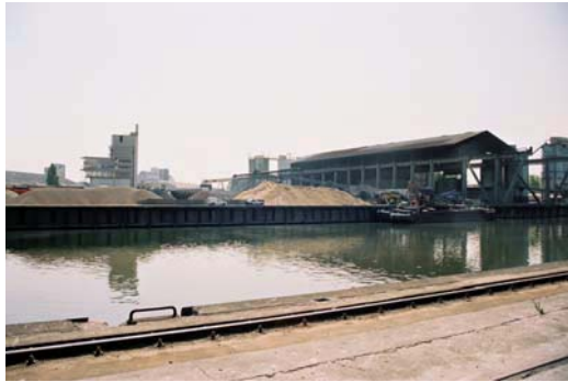
Vue sur la darse n°1 et la cimenterie
