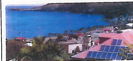
Production solaire photovoltaïque en toiture
