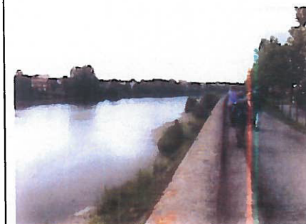
Piste cyclable sur digue le long de la Garonne à Toulouse
