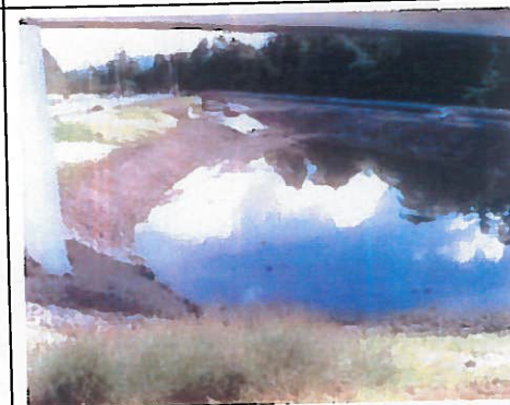
Stockage des eaux pluviales échangeur canal du Lamentin - Martinique
