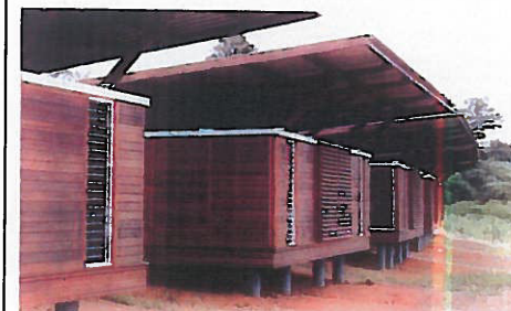
Construction bois – Collège de Papaïchton en Guyane
