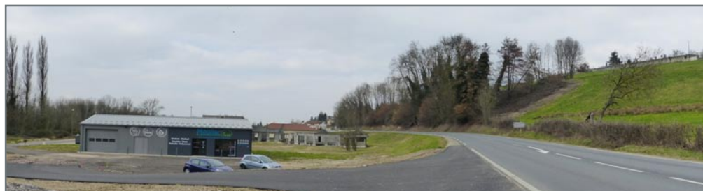
Entrée sud : L'extension linéaire de l'urbanisation le long de la route départementale rend l'entrée de ville peu lisible. Un espace de respiration structure la perception à droite de la route.
