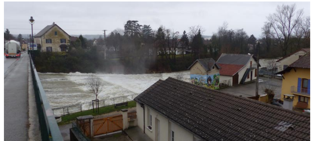
La centrale hydraulique du Guiers.
