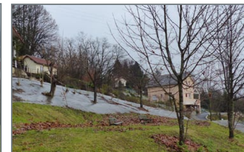
Traitement des limites de propriété avec une bâche plastifiée
