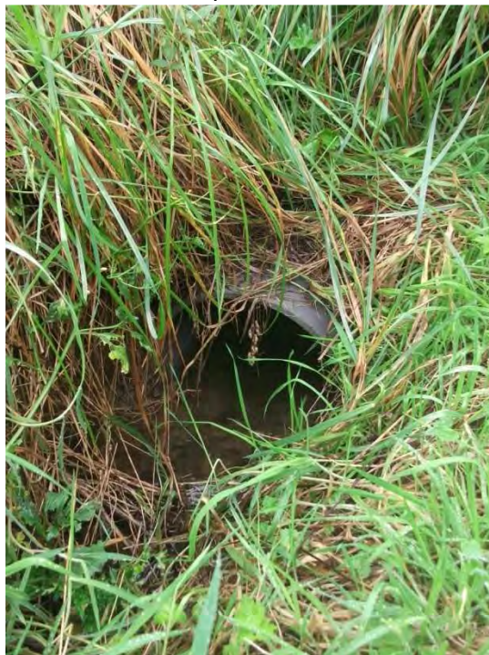
Exutoire du bassin de rétention dans fossé
