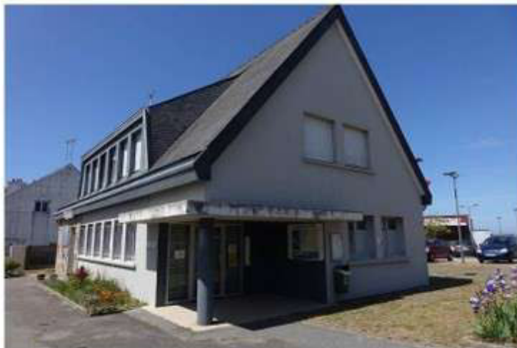
Bâtiment de l'ancien bureau de Poste qui va être démolit et désamianté
