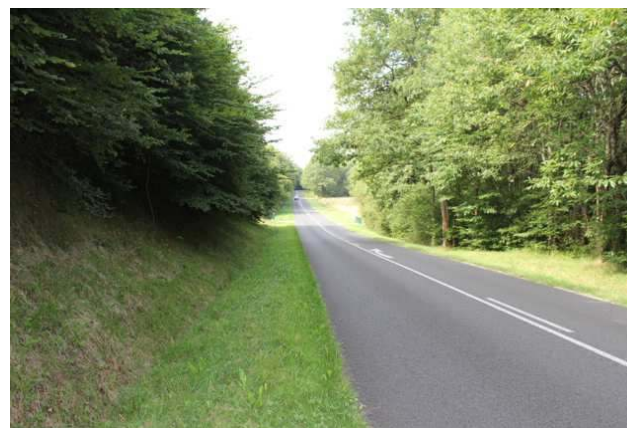
Figure 30 : Coupure de la RD764 au Gué des Forges – bois du Biard (commune du Liège)
