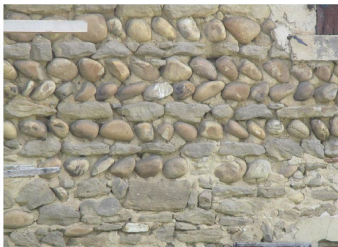
Photographies 46 – Remplissage avec une alternance de galets de rivières et de molasse calcaire (Eco-Stratégie, le 03/08/2017)
