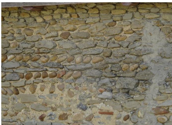
Photographies 46 – Remplissage avec une alternance de galets de rivières et de molasse calcaire (Eco-Stratégie, le 03/08/2017)
