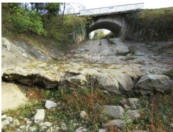
Photographies 67 – Seuils bétonnés, au niveau de la Savasse aux Fayolles et au niveau du Chalon au niveau de la RD 517 (Eco-Stratégie, le 26/10/2017)
