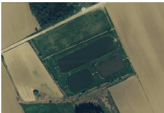
Station d'épuration de Saint-Bonnet
