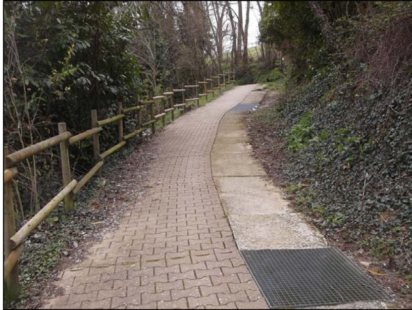
Photographie 2 : Galerie en demi-buse (2 Avril 2015)
