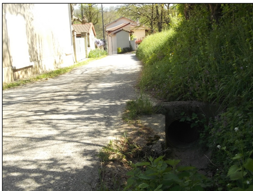
Photographie 4 : Exutoire du BV Treigneux (23 Avril 2015)
