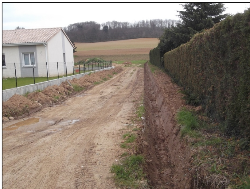
Photographie 3 : Fossé exutoire du bassin Charrière 2 (2 Avril 2015)
