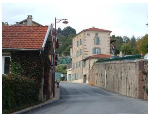
Ancienne ferronnerie 1, rue de l'Eglise
