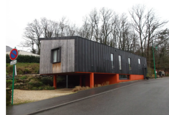
Monterblanc (56) Maison individuelle avec stationnement semi-enterré tenant compte de la topographie du site.
