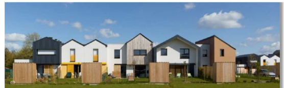
Opération groupée « Vert Buisson » à Bruz (35)
