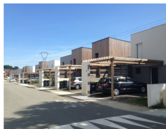
Saint Avé (56) Carport devant les maisons permettant d'animer la façade sur rue exposée au Nord.
