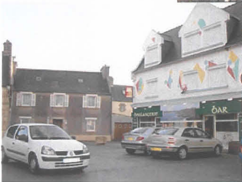
Bourg dense mêlant architecture traditionnelle et architecture plus récente
