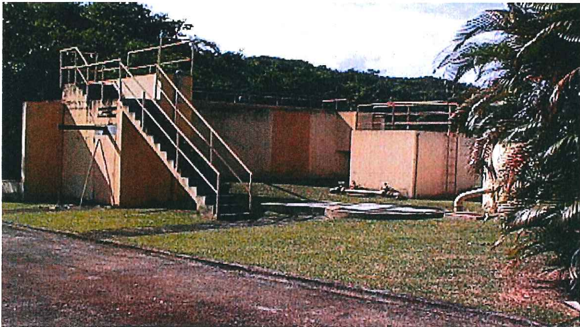
Station de traitement d'eaux usées du Bac
