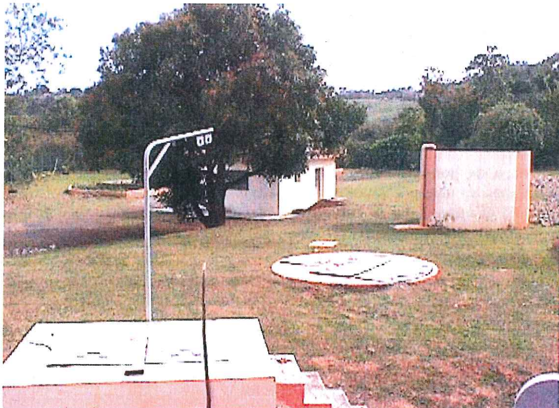
Station de traitement d'eaux usées de Tartane
