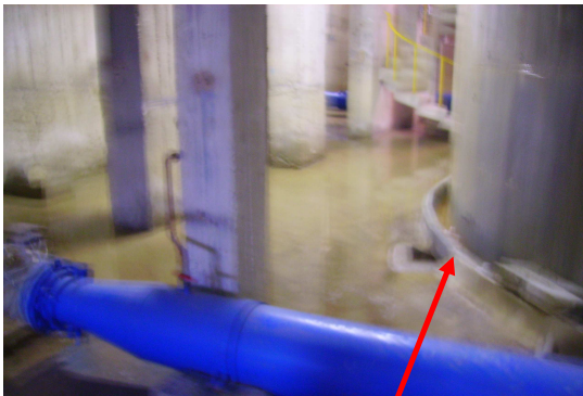
Muret au pied de la bâche 300 m 3
