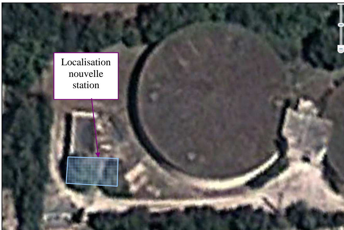
Figure 4-36 : Emplacement envisagé pour la nouvelle station de pompage
