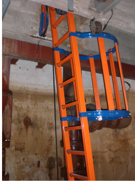
Figure 4-25 : Accès à l'intérieur de la bâche de 300 m 3
