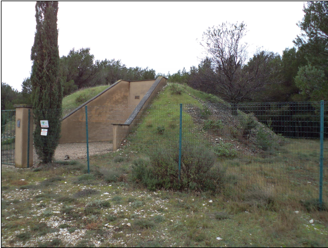
Figure 4-20 : APS n°3 – Réservoir La Chapelle – Cuve existante
