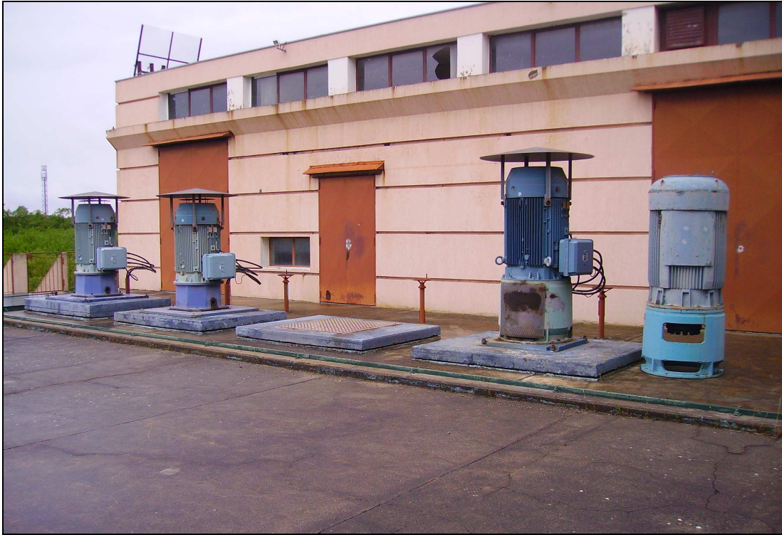
Figure 4-27 : Vue du toit de la bâche de 700 m 3 - 4 pompes – 21 mai 2012
