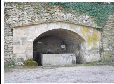
129. Lavoir, Derrière La Font, B 452
