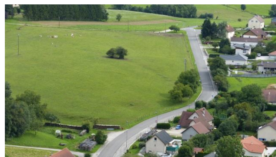
Vue aérienne de la RD 141 traversant Arguel
