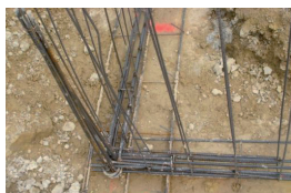
Noeud de chaînage - Continuité mécanique
