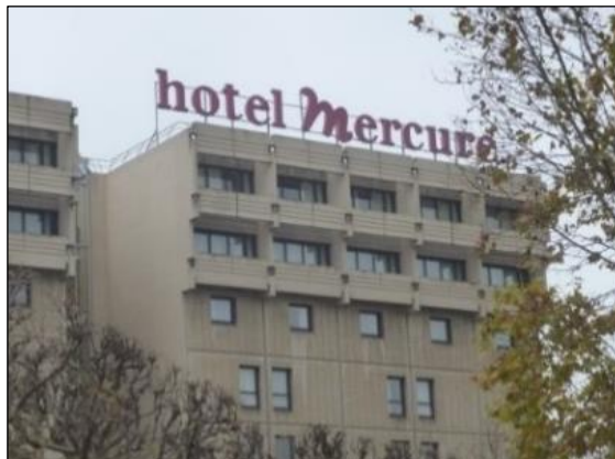
enseigne en toiture
