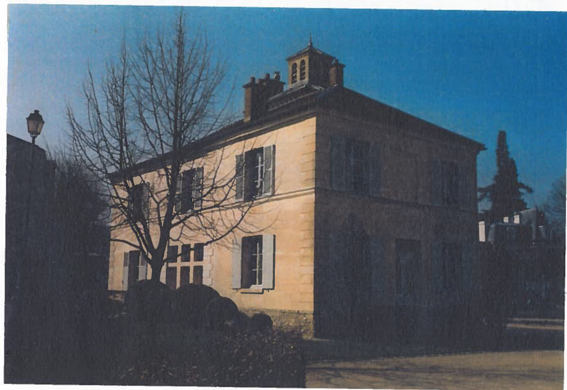
MAT D'ECLAIRAGE PUBLIC DERRIERE LA MAIRIE
