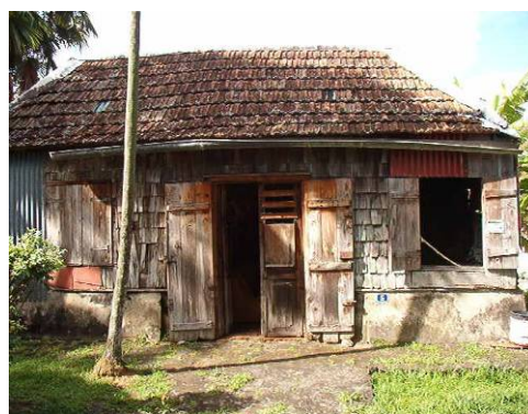
case traditionnelle avec revêtement en essentes sur façade
