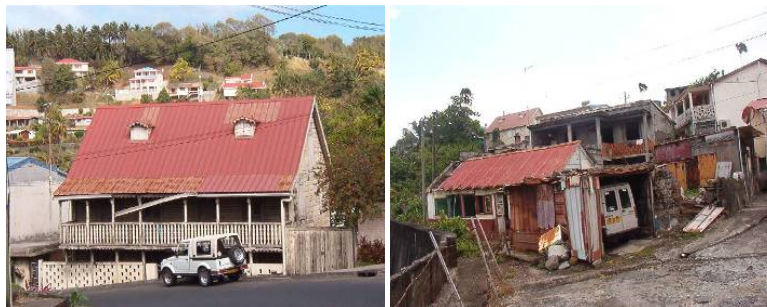
Construction inhabitée à l'entrée nord du bourg
