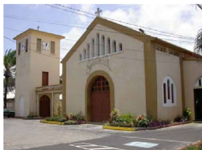
Eglise paroissiale Saint Paul
