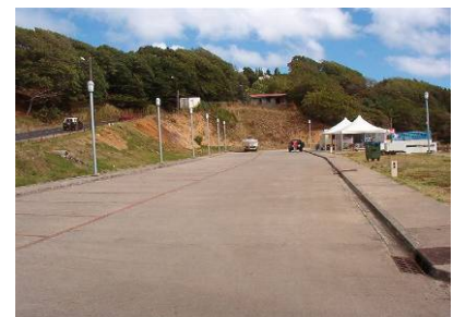
Parking aménagé entre la RN1 et le port de pêche
