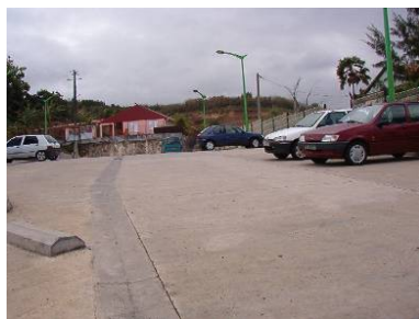
Parking aménagé non loin de l'église
