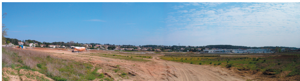
«La Plaine» travaux d'aménagements en cours
