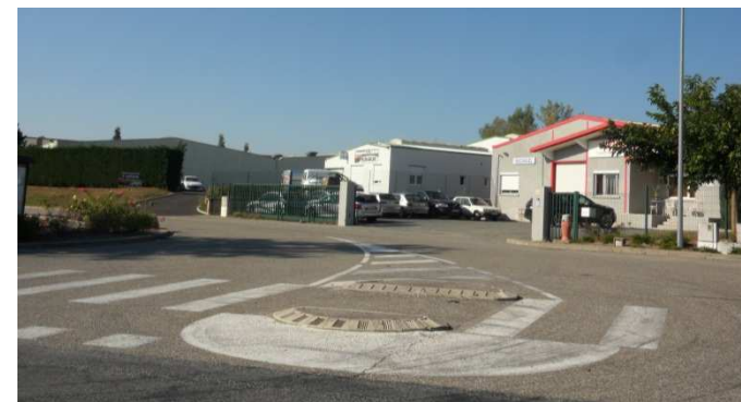
Extension en cours
