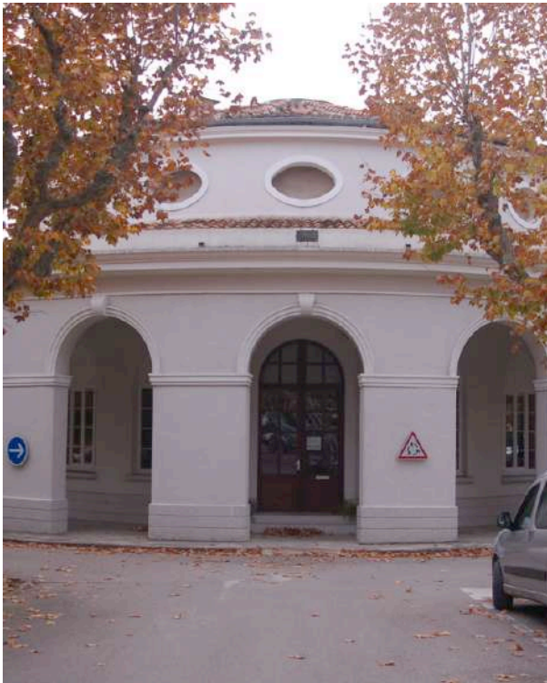
Façade en ciment
