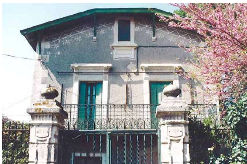
Villa du «Professeur Tadenat» 2, rue du Prf. Tadenat - vers 1910
