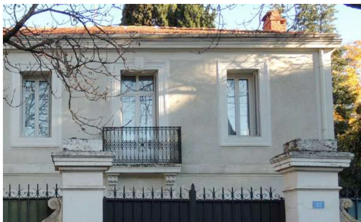
Le remplacement de la fenêtre par un modèle strictement identique à celui d'origine est quasiment imperceptible
