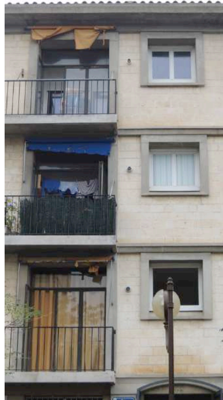
Cité Astruc menuiseries en PVC et menuiseries d'origine en acier
