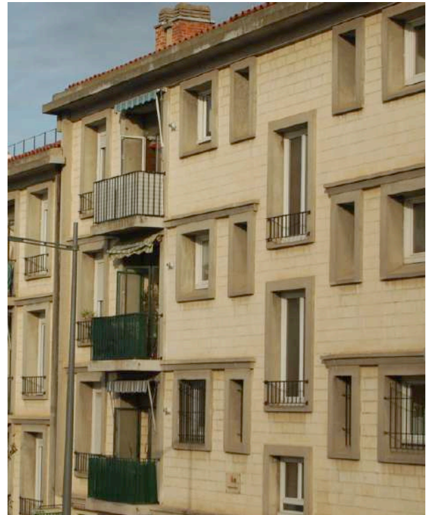
Structure en béton, mur en pierre Cité Astruc
