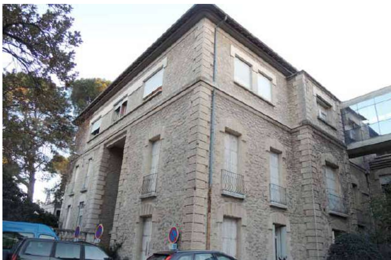
Clinique Beausoleil avenue de Lodève à partir de 1933 - Architecte E. Leenhardt
