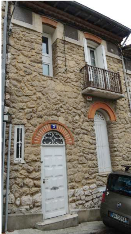
Rue Yvan, menuiseries bois remplacées par du PV
