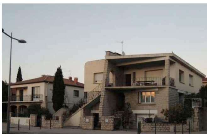
Pavillons 1950/1970 toit terrasse
