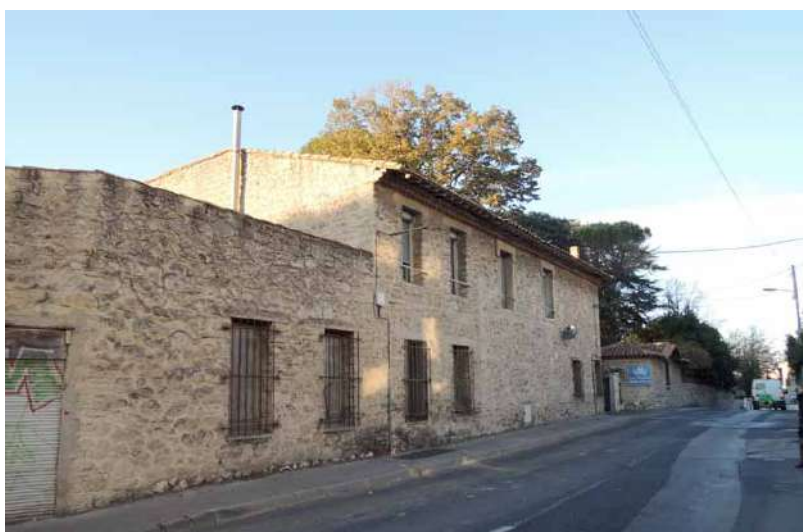
Clinique des Violettes à partir de 1905 Architecte E. Leenhardt ? À VERIFIER
