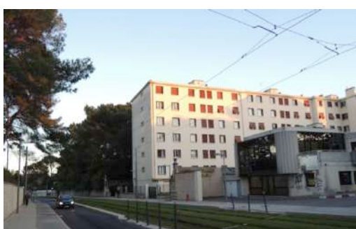
Immeuble St-Georges, avenue de Lodève
