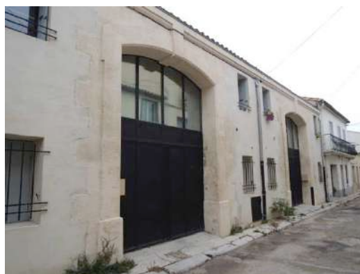
Hangar réhabilité rue de Constantine
