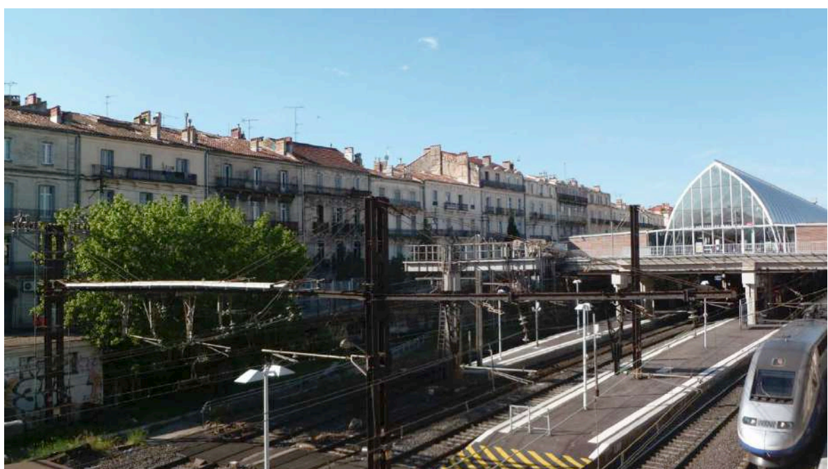
Façades de la rue des Deux Ponts
