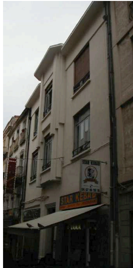
12 rue Boussairolles (architecte Carlier)
