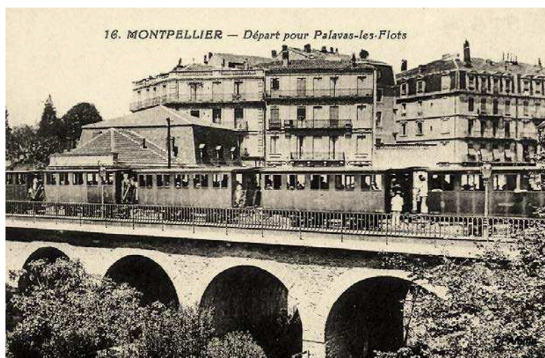
Viaduc, l'école de garçon et les immeubles de l'avenue Mistral
