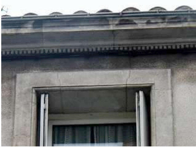
13 rue Frédéric Bazille Corniche à denticules en pierre de taille
