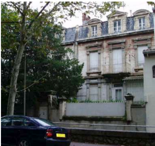
Maisons 17,19 avenue du Pont Juvénal
