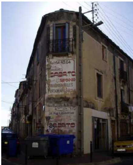
22 rue Lamartine, 23 rue de l'Aire
