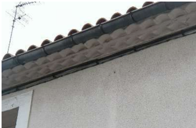
42 rue des Aiguerelles Débord de toit sur génoise deux rangs avec gouttière pendante en zinc.
