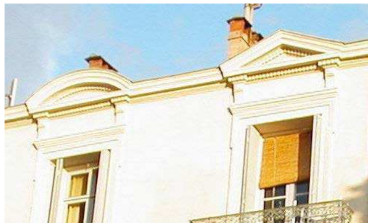
1 rue Du Guesclin Frontons en pierre taillée couvrant les baies des derniers niveaux
