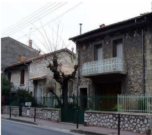
14,16 avenue de Palavas, maisons avec décor en frise. Façades en moellons de pierre début XX e siècle
