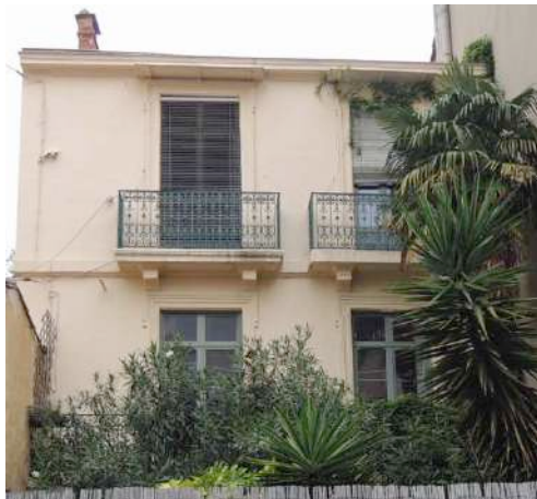
Le remplacement de la fenêtre par un modèle strictement identique à celui d'origine est quasiment imperceptible
