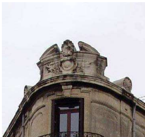
1 rue Du Guesclin Frontons en pierre taillée couvrant les baies des derniers niveaux
