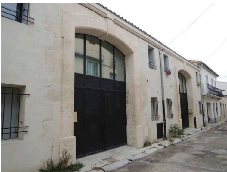
Restructuration de remises
