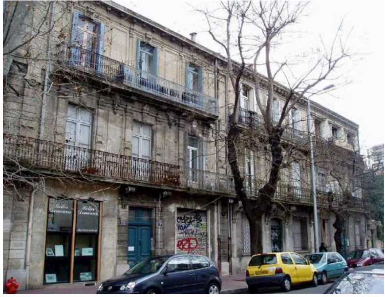
9, 11, 13 avenue du Pont Juvénal
