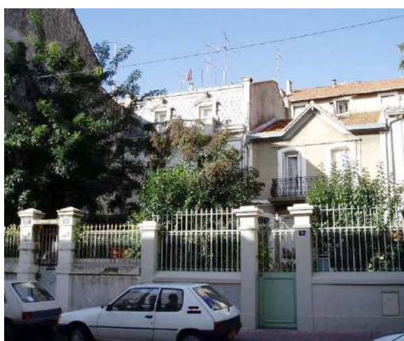
Maisons en bande 8, 10 rue Peyson
