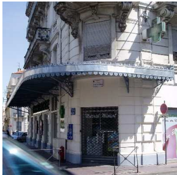
2 rue Frédéric Bazille Marquise métallique
