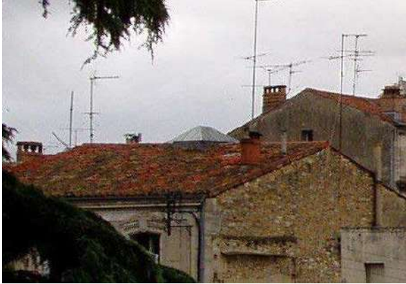
4 avenue du Pont Juvénal
