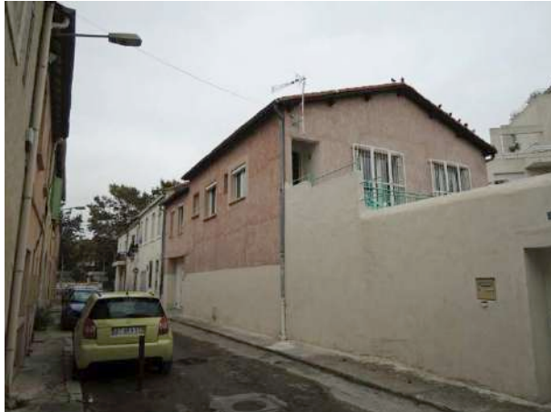
La mise en place d'une ITE est parfois envisageable, en prenant en compte le caractère du bâtiment et sa nouvelle insertion urbaine, tout en préservant les modénatures existantes
