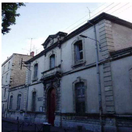
Ecole rue du Général Riu
