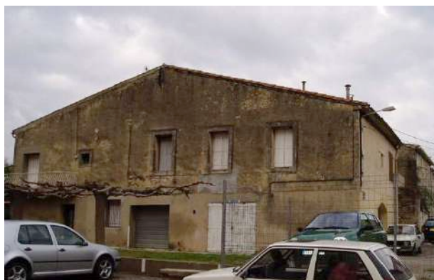
Extrémité sud de la rue du Canal
