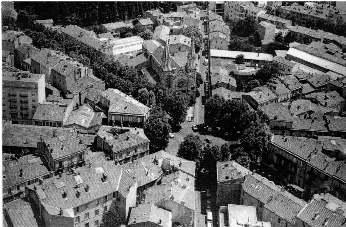
Place Sadi-Carnot, la première église des Saint-François avant sa démolition (construite par Julien Boudes entre 1876 et 1901, démolie en 1995).
