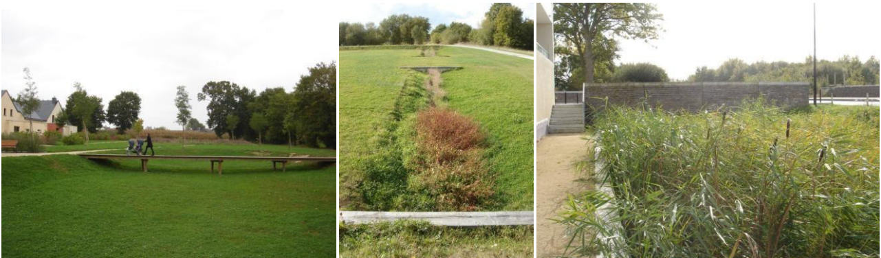
Exemple de bassins paysagés et noues plantées
