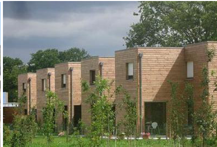
Une forme en L qui permet de ménager un espace d'intimité (Rennes, architectes : M. Rigourd, I. Hiault)
