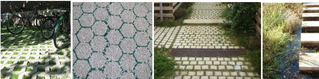
Exemple de matériaux perméable : dalle béton enherbée, gravillons, pavés non jointoyés, pas japonais
