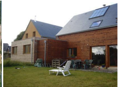
Ou par une dépendance (Langouët, architecte : Menguy)
