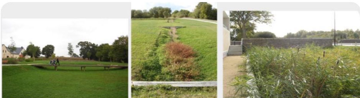
Exemple de bassins paysagés et noues plantées
