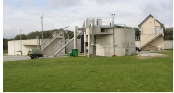
Station d'épuration de Saint-Renan
