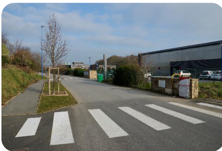
Aménagements intérieurs de la zone d'activité
