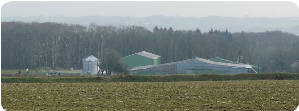
Exploitation agricole avec silo et bâtiments en milieu ouvert, sur Saint-Renan
