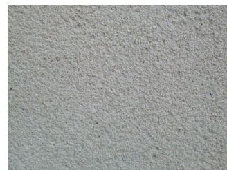
Enduit à la chaux gratté fin.
