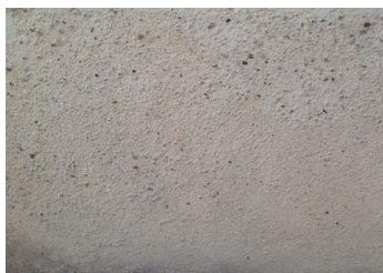
Enduit à la chaux brossé.
