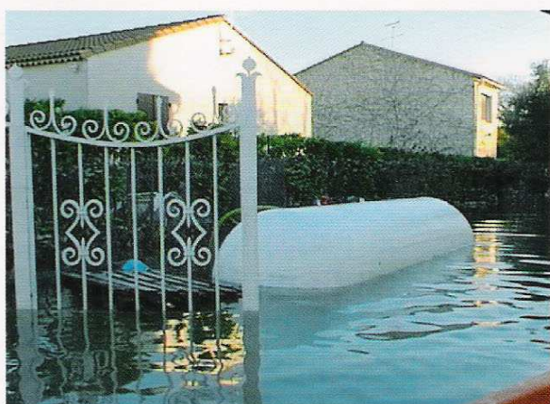
Cuve soulevée par l'eau.
