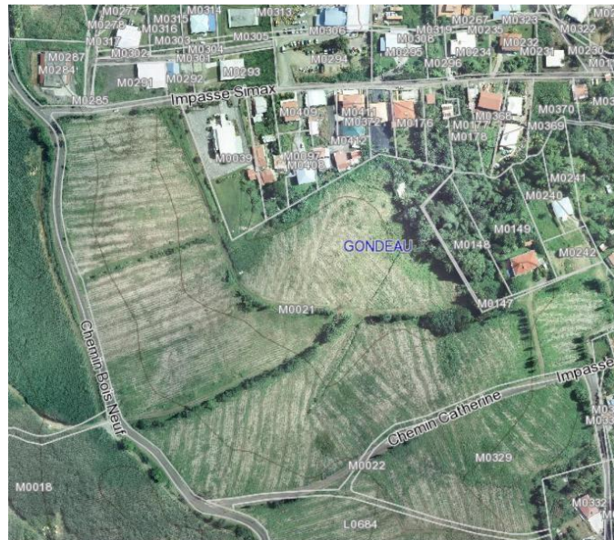
Figure 5 : Vue aérienne parcelle M21 - secteur Gondeau
