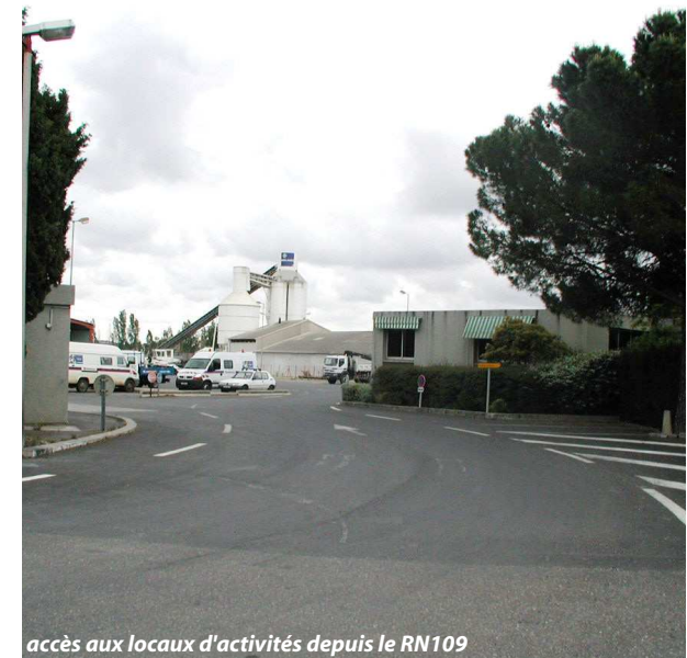
accès aux locaux d'activités Ouest
