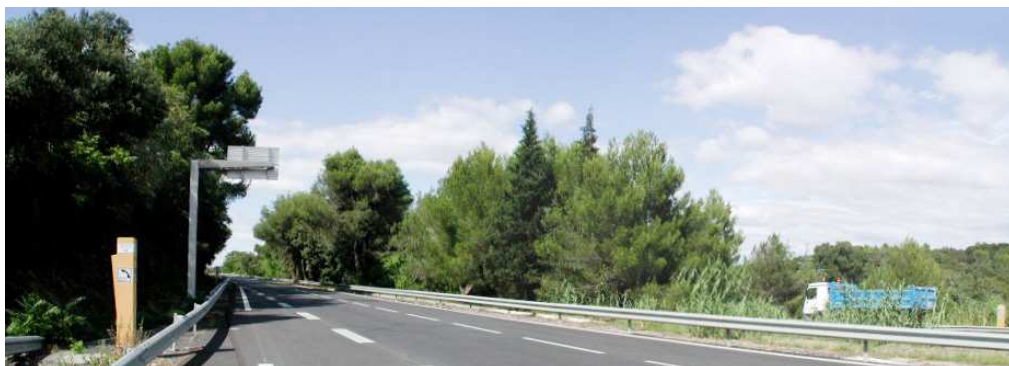
vue sur le site de Courpouiran depuis la RN109 (sens de circulation : Lodève vers Montpellier)
