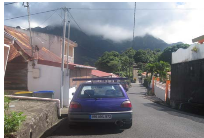
Réseau de collecte des eaux pluviales de part et d'autre de la route
