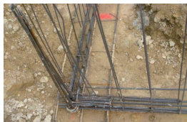
Noeud de chaînage - Continuité mécanique
