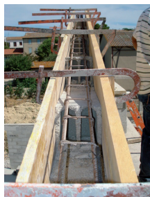
Mise en place d'un chaînage au niveau du rampant d'un bâtiment
