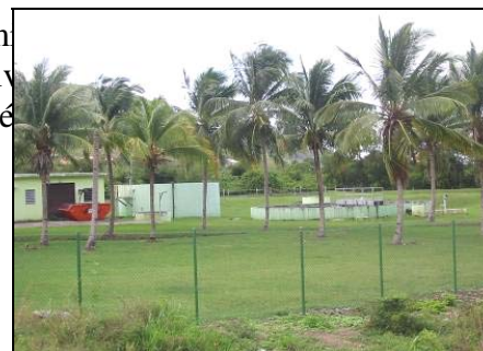
Station d'épuration à l'entrée du bourg
