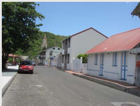
Vue d'ensemble de la rue des Arlésiens
