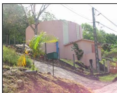
Réservoirs sur la RD7 à gauche et de Gallochat à droite
