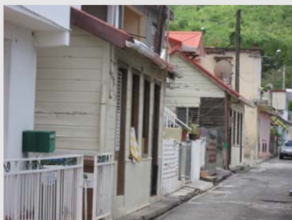
Vue d'ensemble de la rue Pavilla
