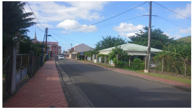
8 Vue sur la rue et les premières constructions du bourg des Anses d'Arlet, localisé à la frange du Sud du site de projet. Les constructions, localisées à l'alignement, sont généralement de hauteurs limitées (RDC, R+1 max près de la mairie). On aperçoit également le clocher de l'Eglise Saint-Henri, inscrite aux monuments historiques.
