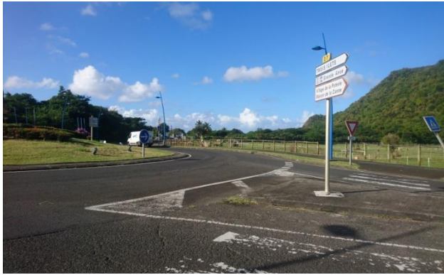
Rond point de l'entrée du bourg (carrefour RD7 / RD37)
