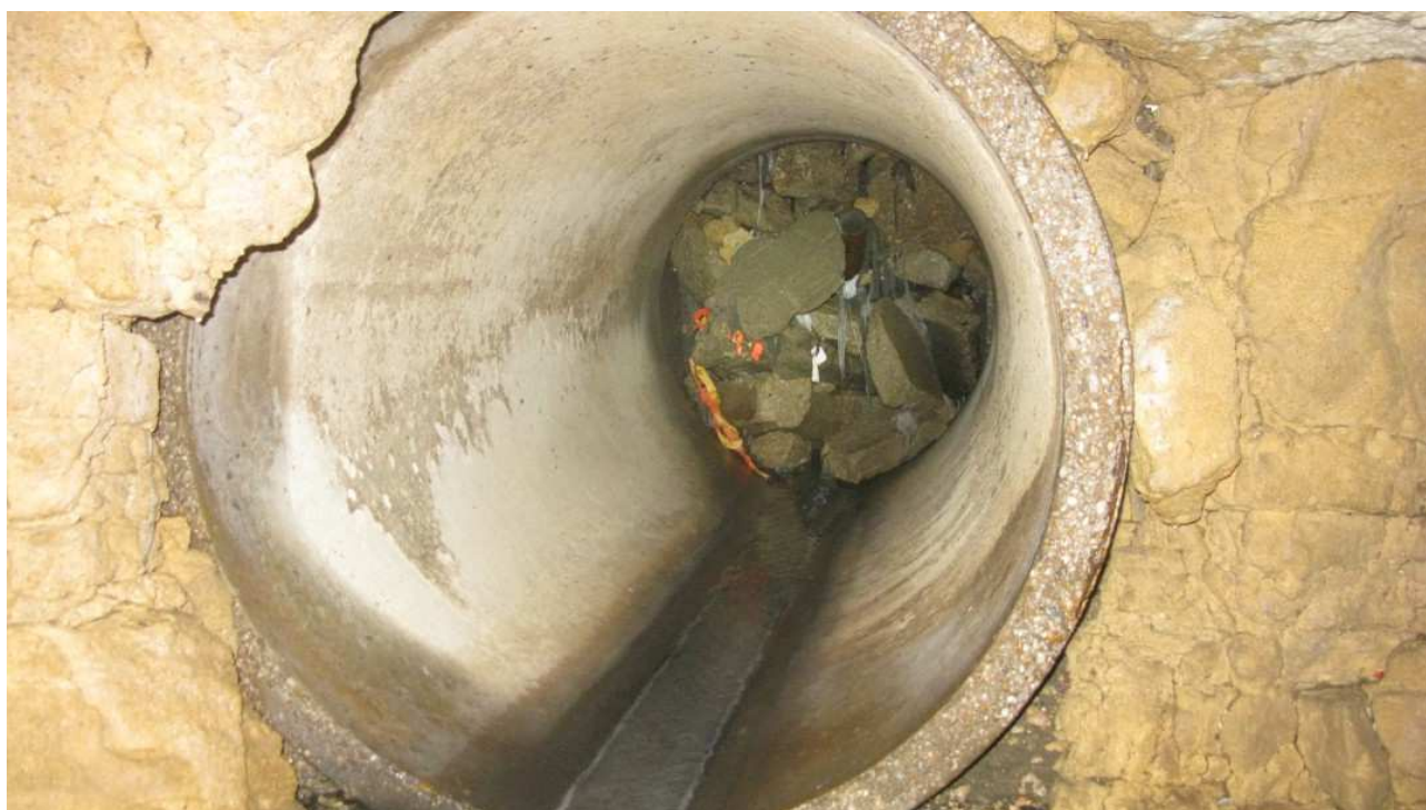
Vue de la conduite depuis la galerie
