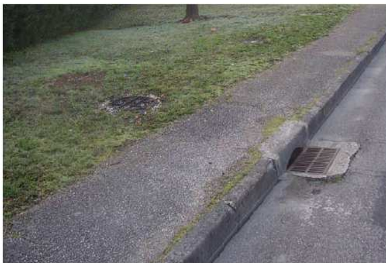
Exemple : Avaloir relié à un puits d'infiltration
