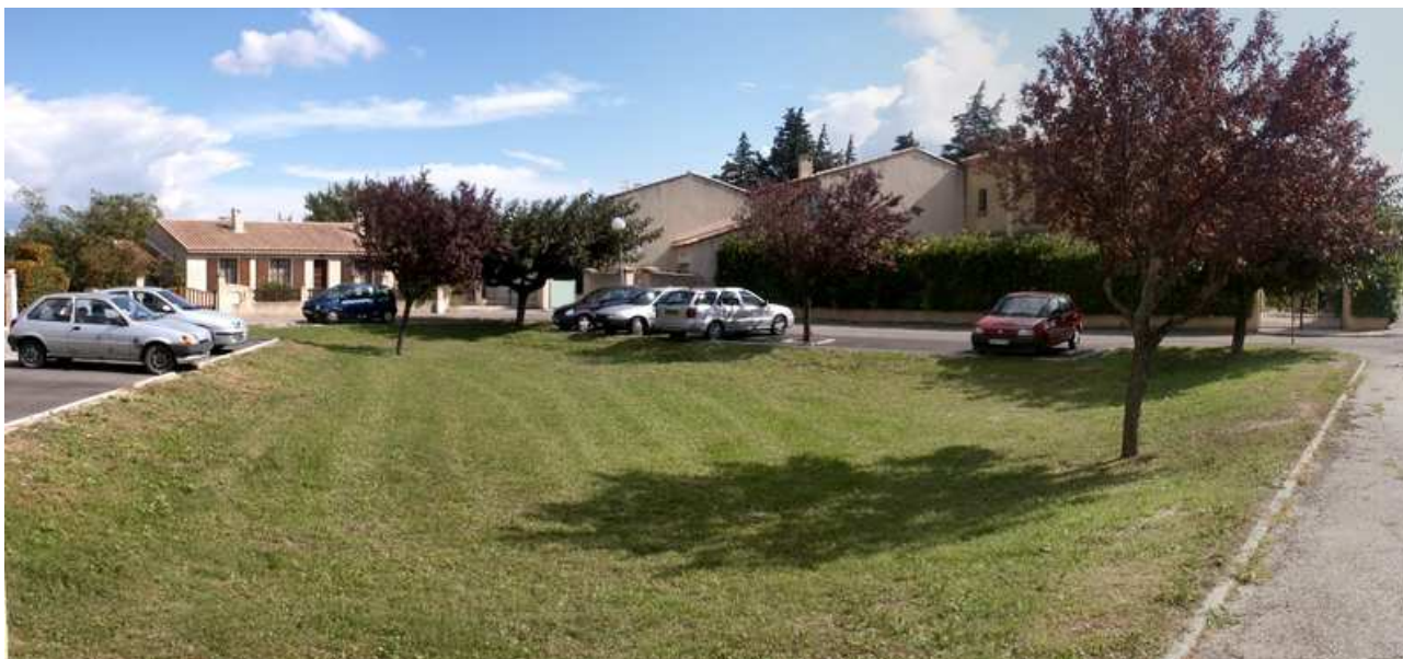
Exemple de bassin de rétention intégré dans un lotissement (bassin de faible profondeur enherbé infiltrant)
