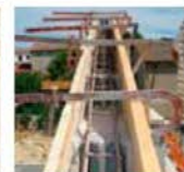
Mise en place d'un chaînage au niveau du rampant d'un bâtiment
