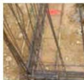
Noeud de chaînage - Continuité mécanique
