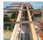
Mise en place d'un chainage au niveau du rampant d'un bâtiment
