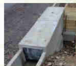
Installation de passage à petite faune lors de la réfection d'une départementale © Les corridors écologiques
