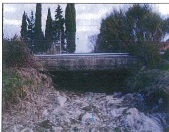
Aval du pont
