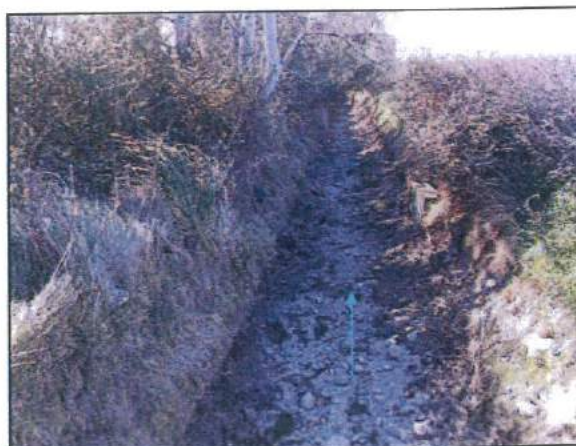
Canal à l'aval du pont
