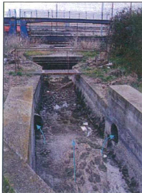
Aval de l'ouvrage – Deux surverses
