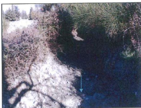
Canal en amont du pont
