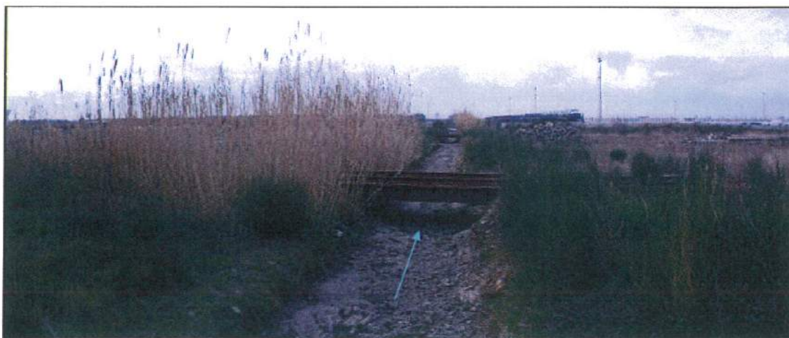
Canal à l'aval de l'ouvrage
