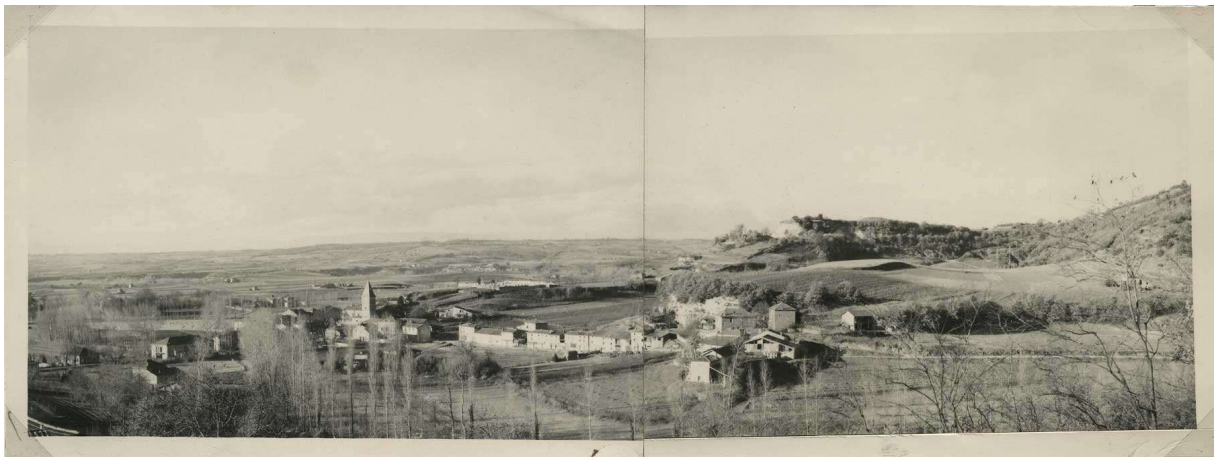
Photographie 41– Vue depuis l’est, dans les années 1950 (SOURCE : http://fdfclaveyson.free.fr )
