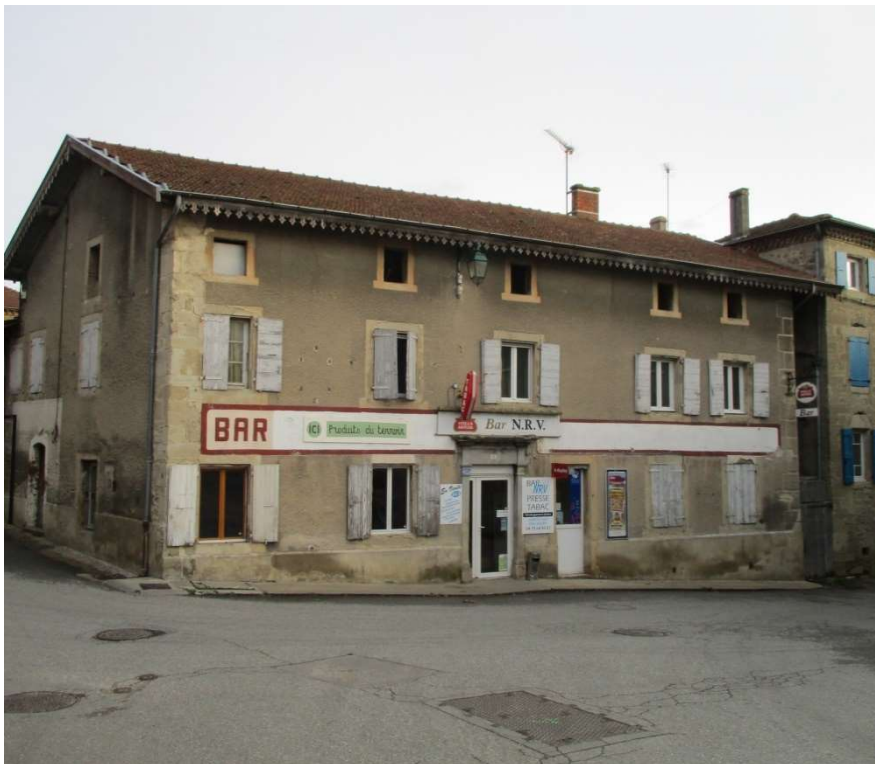
Photographie 52 – Exemples de façades de constructions anciennes (Source : ECO STRATEGIE, 10 octobre 2015)
