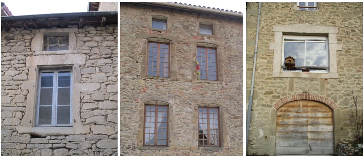
Photographie 54 – Exemples de fenêtres et chainages en pierre de taille (Source : ECO STRATEGIE, 10 octobre 2015)
