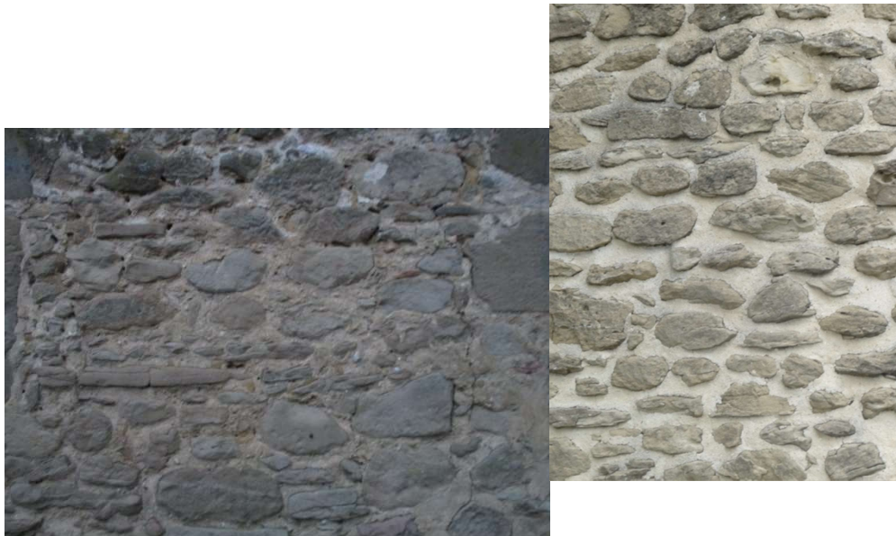
Photographie 53 – Exemple de pierres apparentes avec jointoiment (Source : ECO STRATEGIE, 10 octobre 2015)
