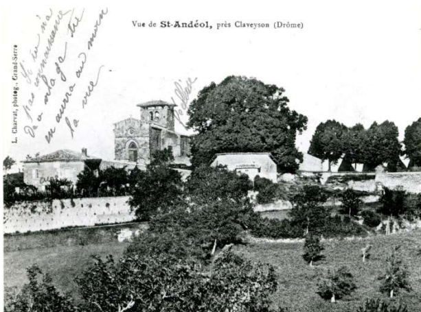
Vue depuis le sud-ouest
