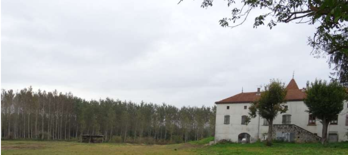
Photographie 26 – Tilleuls devant maison forte à proximité de Modichère (Source : ECO STRATEGIE, le 10 octobre 2015)
