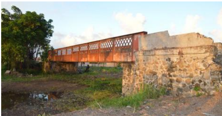
Le Pont Bac (Rivière Salée) – Crédit Photo: Service communication de la Ville de Rivière Salée
