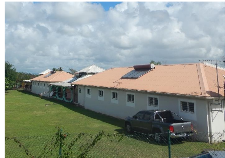
Logements équipés de chauffe-eau solaires à Rivière Salée Source : EVEN Conseil – Avril 2016
