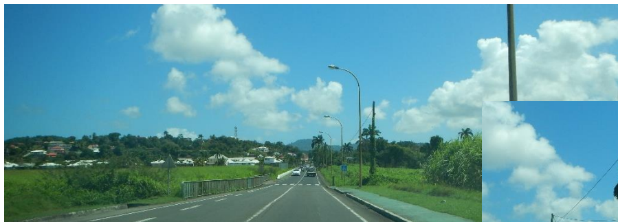
1. L'entrée sur Petit Bourg, depuis la Route Nationale 7 Source : EVEN CONSEIL-février 2016
