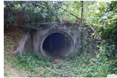
Ouvrage d'art et ravine qui collectent une grande partie de l'eau pluviale. Ravine utilisée par les riverains (jardins potagers et petits escaliers de bois).
