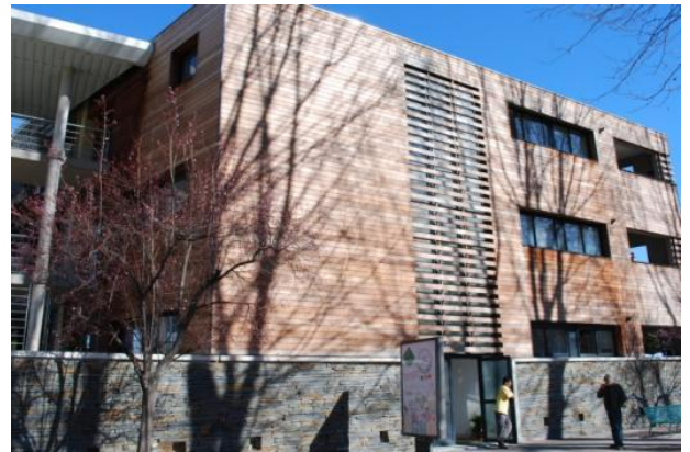
Illustration 4: Réhabilitation d'un bâtiment avec pose d'un bardage bois, Lycée Déodat de Séverac, Céret, source AURCA.
