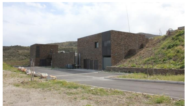
Illustration 63 : Station d'épuration de Banyuls-sur-Mer, source AURCA
