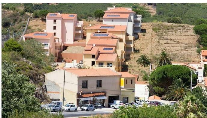
Illustration 29: Panneaux photovoltaïques en toiture, Banyuls-sur-Mer
