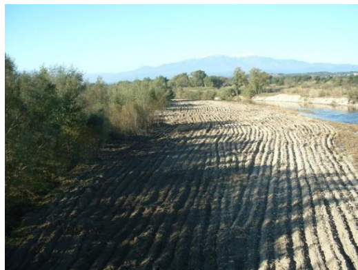
Illustration 7: Travaux de restauration des rives du Tech, (source SIGA du Tech)
