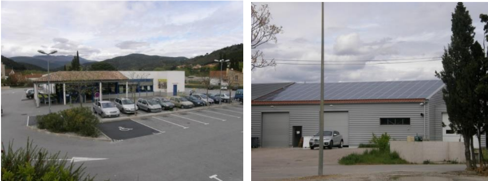
Lidl, zone commerciale la cabanasse, Reynès, toiture photovoltaïque, zone commerciale Tech Oulrich (Source : AURCA)
