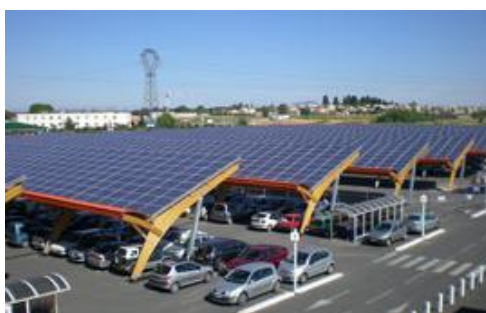
Figure 7. Ombrières photovoltaïques sur une aire de stationnement
