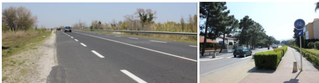
RD81 au franchissement du Tech et dans Argelès Plage.
