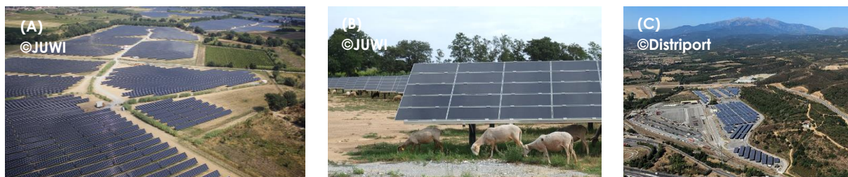
Parc agri-solaire d'Ortaffa (A et B), et ombrières photovoltaïques sur le parking du Distriport du Boulou (C).
