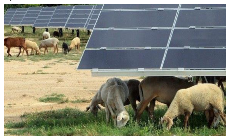
Figure 4. Centrale agrosolaire d'Ortaffa, source « faiteslepleindavenir.com »
