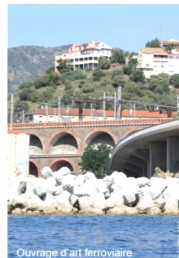
Ouvrage d'art ferroviaire
