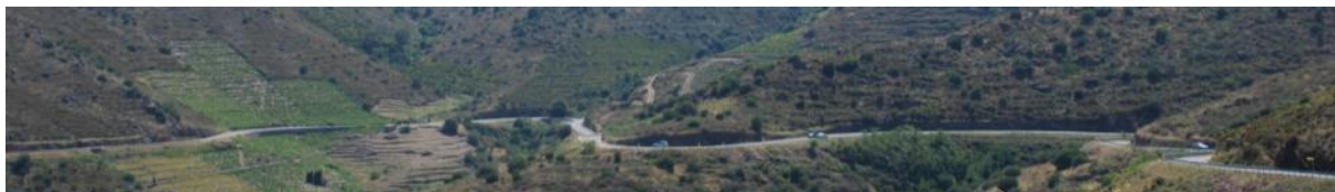
RD914 entre Paulilles et Port-Vendres (haut), route sinueuse entre Banyuls-sur-Mer et Cerbère.
