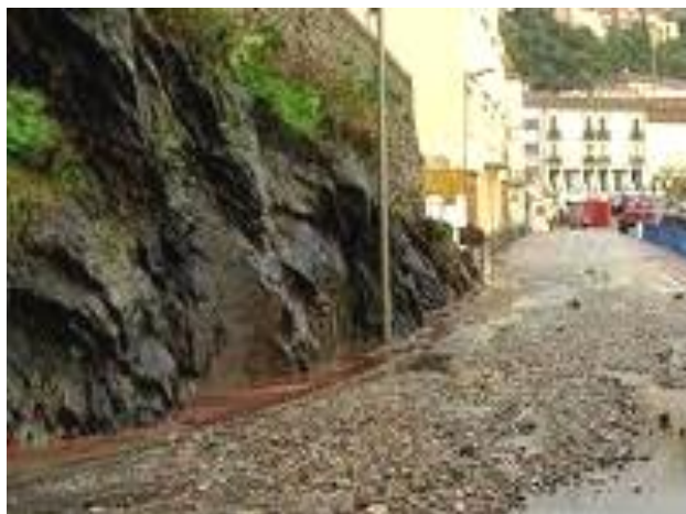
Coulée de boue et éboulement à Cerbère en novembre 2011.
