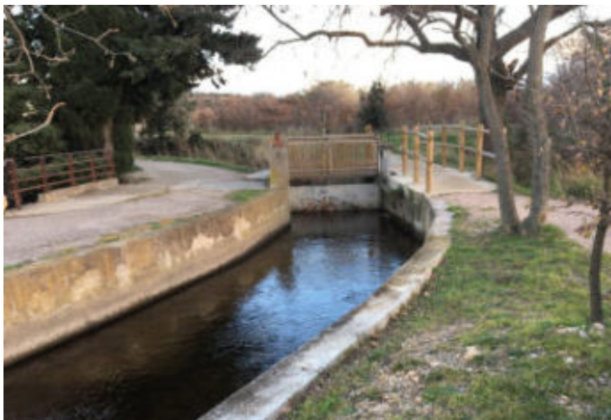
Illustration 15 : Prise de vue de la vanne de contrôle du débit du canal de Perpignan et vanne de décharge rive droite
